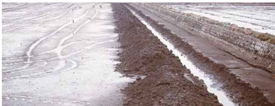
▲挖土機在池塘四周挖深溝，再利用抽水機抽排滲入溝內之水
