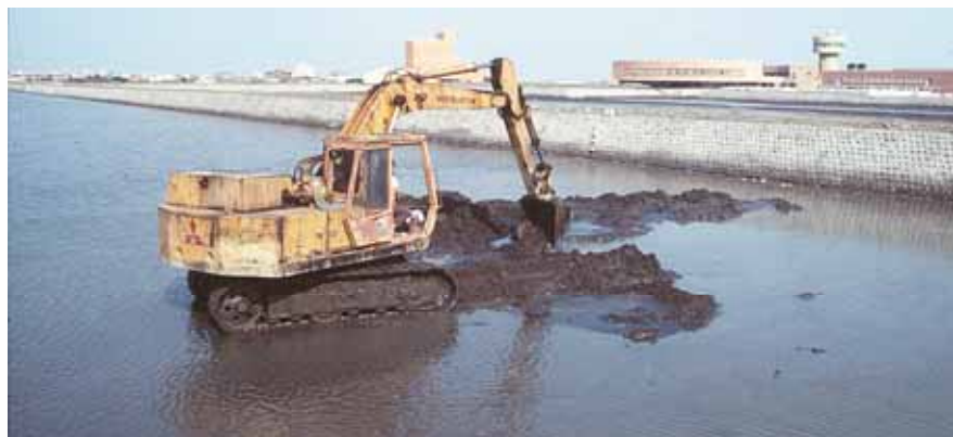
▲池底有機質厚度超過 10 cm 以挖土機翻土 1 m 以上
