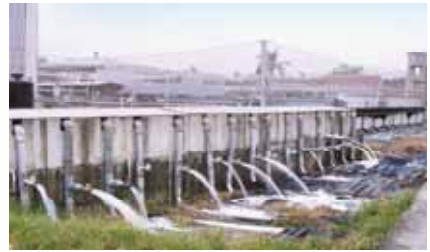
▲地下水進入水庫沉澱
