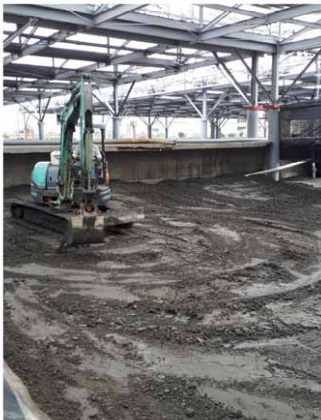
圖 3-1-4 迷你挖土機 (6 噸以下) 進行整池作業
