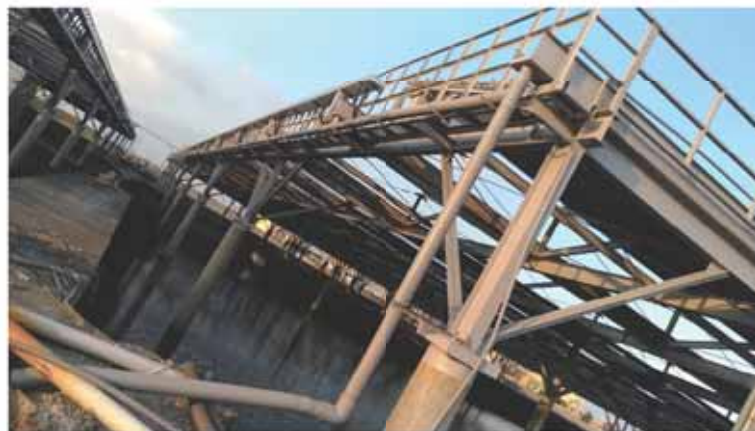
圖 3-1-2 光電設施之排水系統
