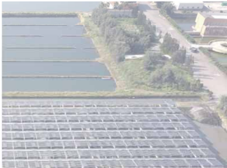
圖 3-1-1 立柱型光電設施
