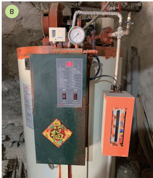
圖 5 A：舊式磚造燒柴火的魚灶；B：新式的高壓蒸氣鍋爐
