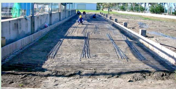
東港生技研究中心「中西區水泥池西側鋪設 RC 及水溝」 施工中
