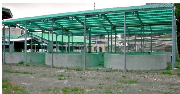
東港生技研究中心「南區新設圓池」竣工
