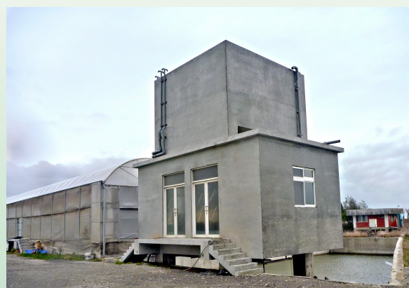
海水繁養殖研究中心「種魚池供水設施工程」
