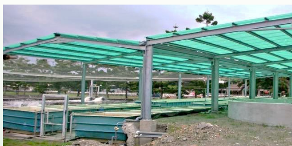
東港生技研究中心「南區新設圓池北側遮雨棚」竣工
