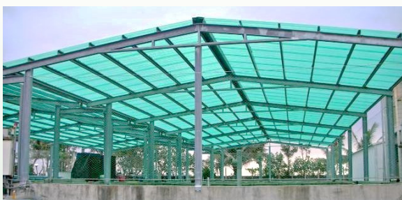
東港生技研究中心「西南側水泥池區遮雨棚」竣工
