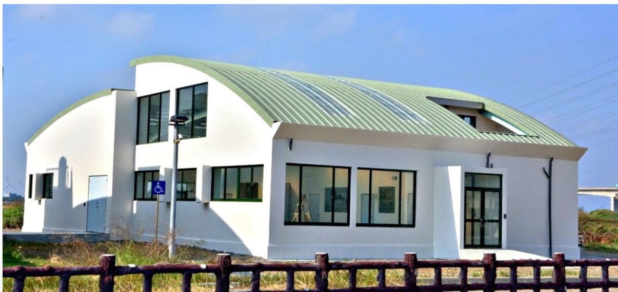
淡水繁養殖研究中心「101 年度淡水觀賞魚種原保種育種及研發設施新建工程」竣工
