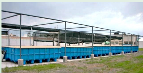
東港生技研究中心「中西區水泥池西側鋪設 RC 及水溝」 竣工
