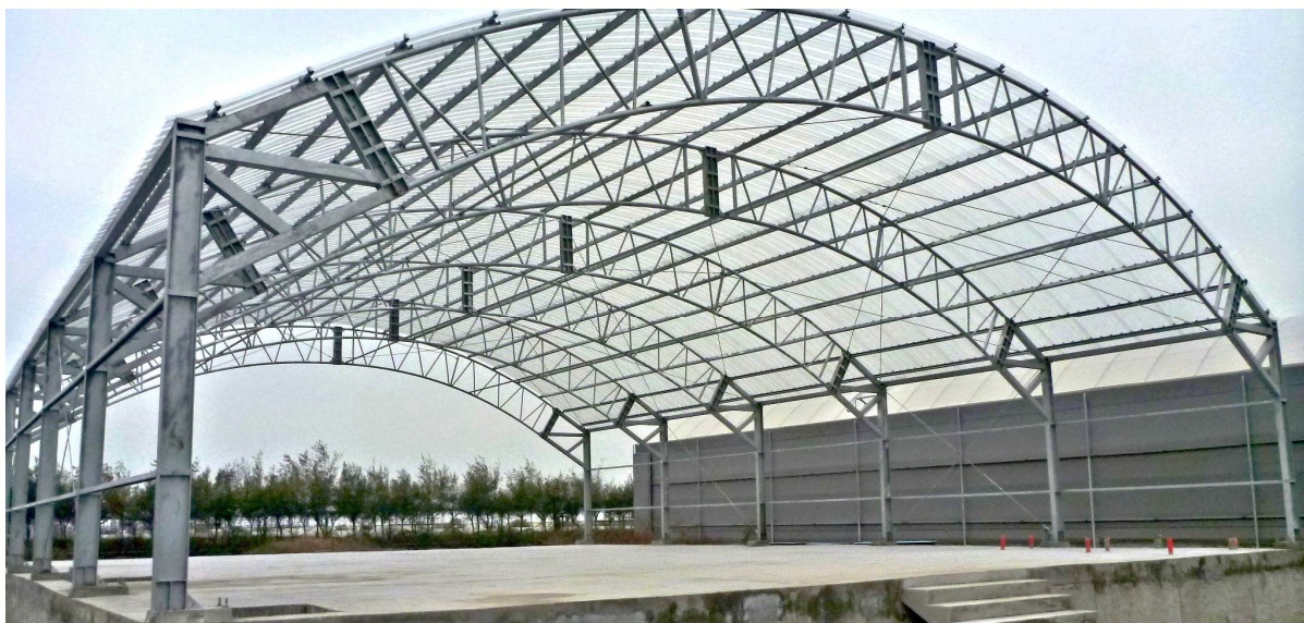
海水繁養殖研究中心「石斑魚中間育成實驗場保溫棚工程」
