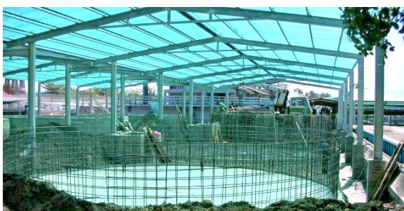
東港生技研究中心「南區新設圓池」施工中
