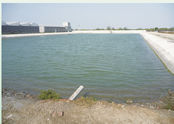
海水繁養殖研究中心「海水蓄水池護坡工程」
