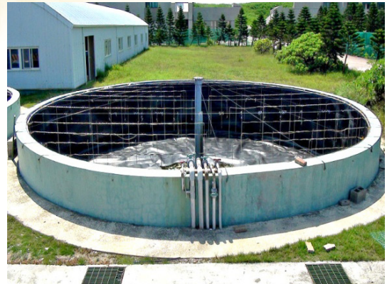
圖 1 200 \text{ m}^3 圓形 HDPE 養殖池
