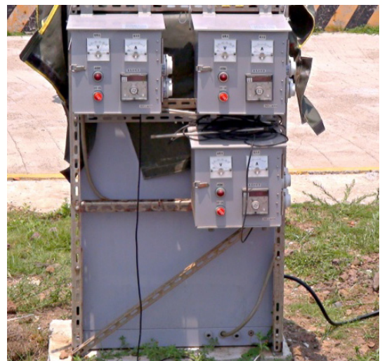
圖 2 溫度控制器 380 V/3 相/30A
