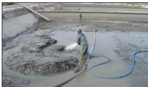
圖 7.25 移除污泥及清洗池底
