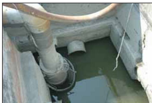
圖 7.10 養鰻池排水口應鞏固好，池塘設置排水溝與排水口連接，捕撈鰻魚時排水溝可作為集魚用，排水口塑膠管可綁網具也可連接自動送鰻機供捕捉鰻魚用
