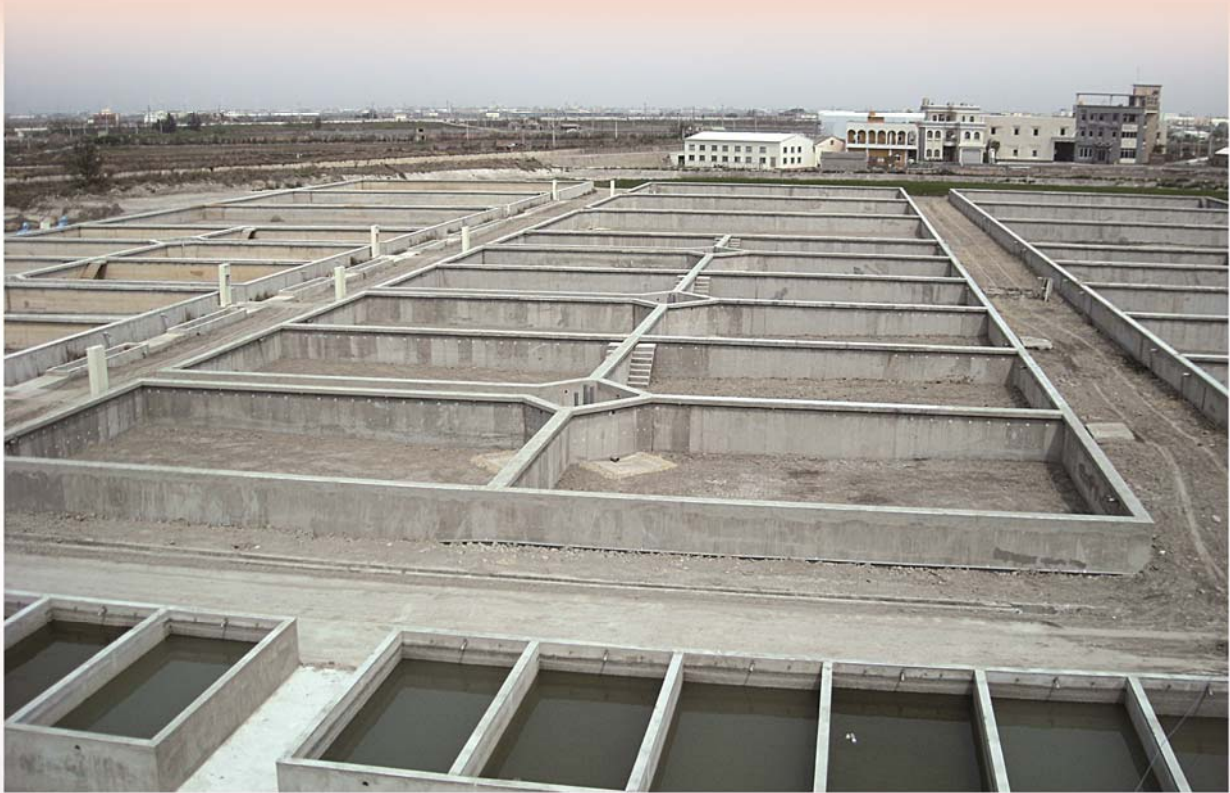
淡水繁養殖研究中心魚池隔堤改建及排水溝整建工程
