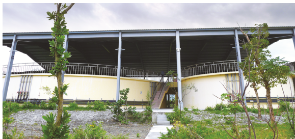
鮪魚培育池鋼骨遮蔭設施完工外觀
