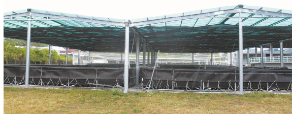
養殖池加蓋浪板鋼構完工外觀
