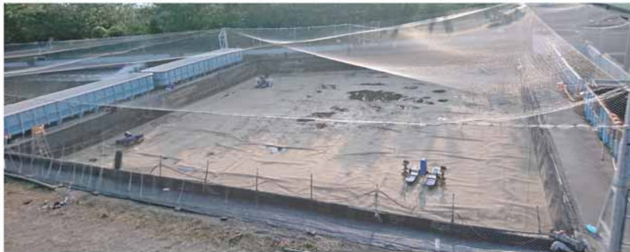
圖 3-1 水產試驗所東港生技研究中心 550 m 2 HDPE 養殖池
