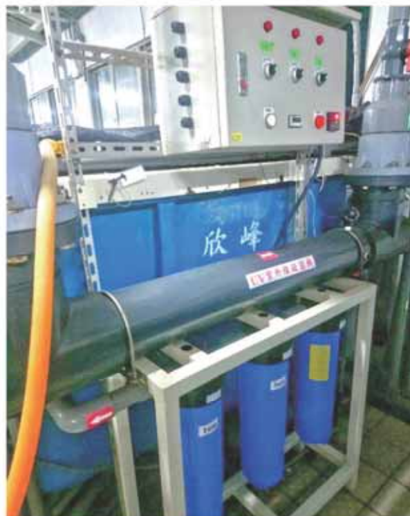
圖 6-3 孵化與育苗用水經過 10、5、1 \mu\text{m} 共 3 道濾心過濾後再以高功率紫外燈殺菌
