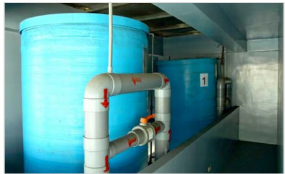
圖 2 循環過濾系統之過濾槽入水口及蛋白除沫機
