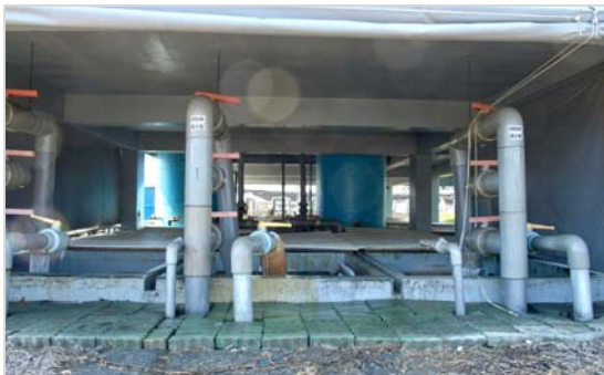
圖 2 循環過濾系統之過濾槽入水口及蛋白除沫機
