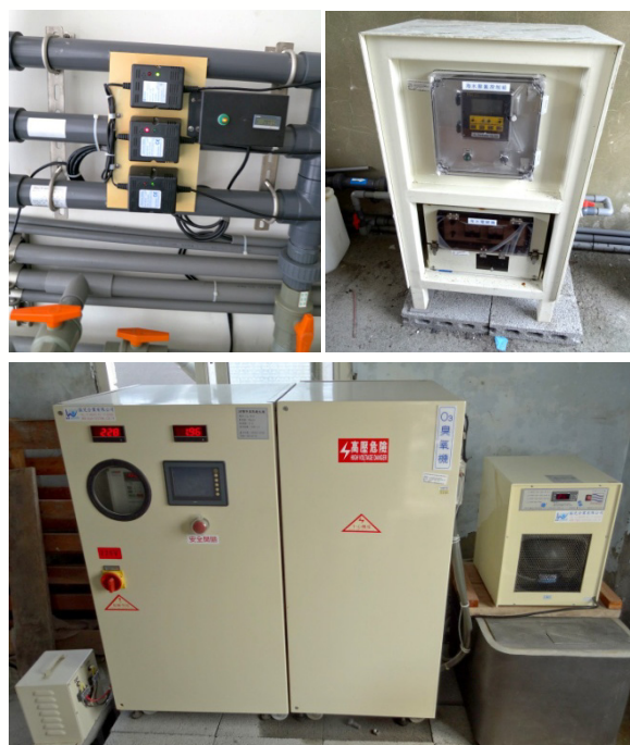
圖 4-9 本中心使用的三種消毒設備。左上：紫外線殺菌器；右上：海水電解器；下：臭氧殺菌器
