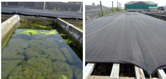
圖 4-11 戶外水處理系統應做好遮陽工作，避免產生藻類
