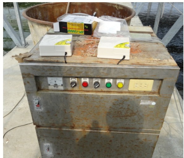
圖 4-6 具備不斷電系統的打氣機
