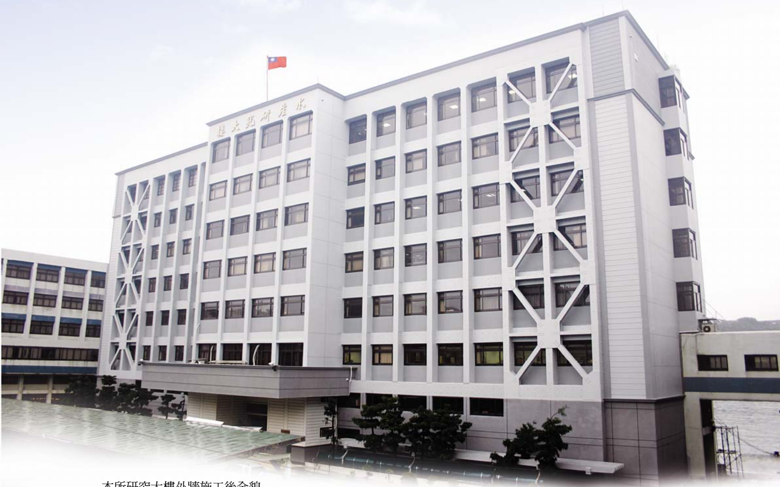
本所研究大樓外牆施工後全貌
