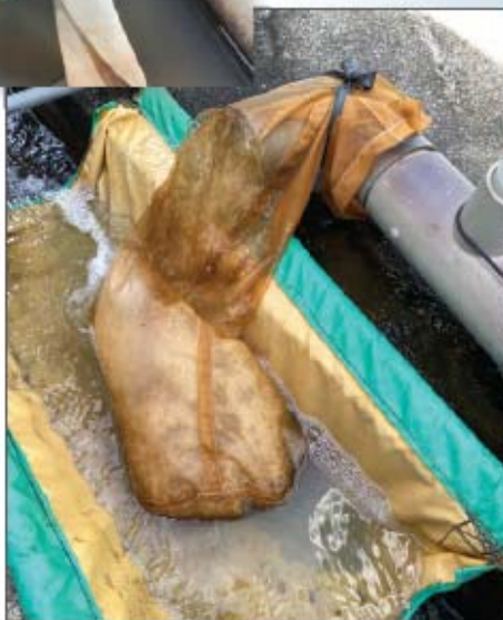
▲ 以帆布隔離具汙染源的水溝
