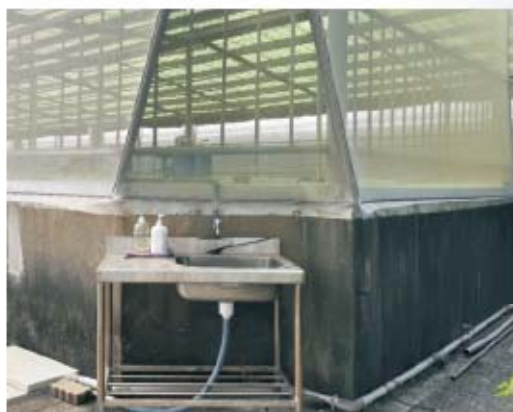
▲ 出入口應具備洗手台
