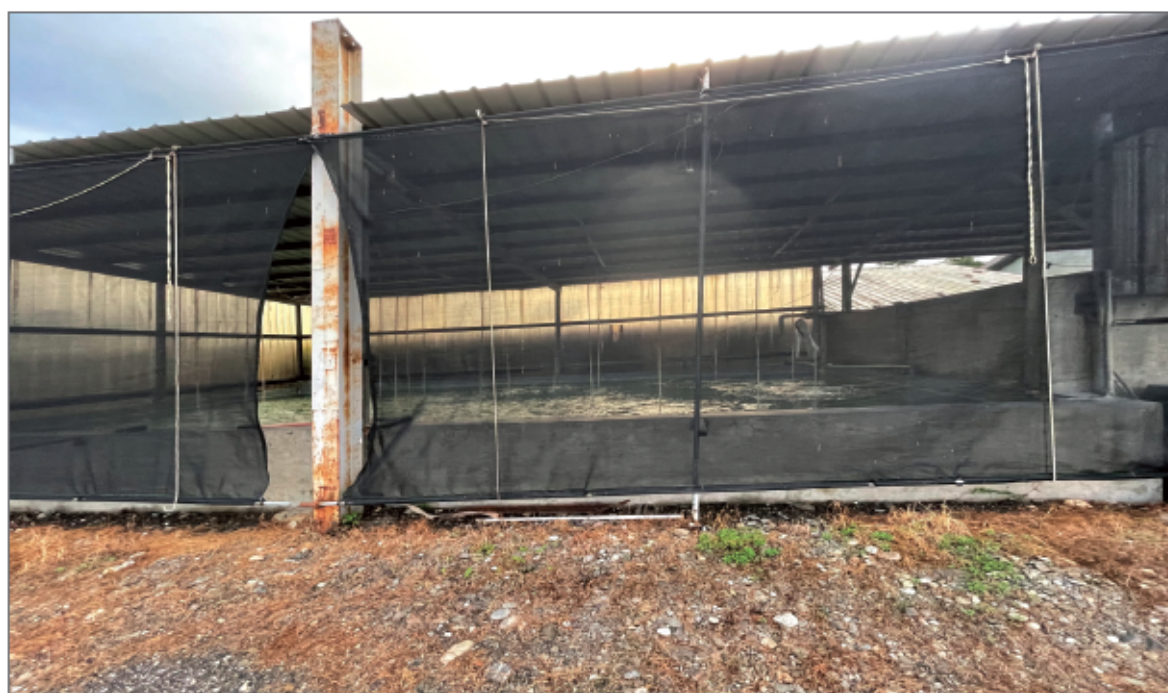
▲ 蓄水池之建置，水源確實過濾消毒再使用
