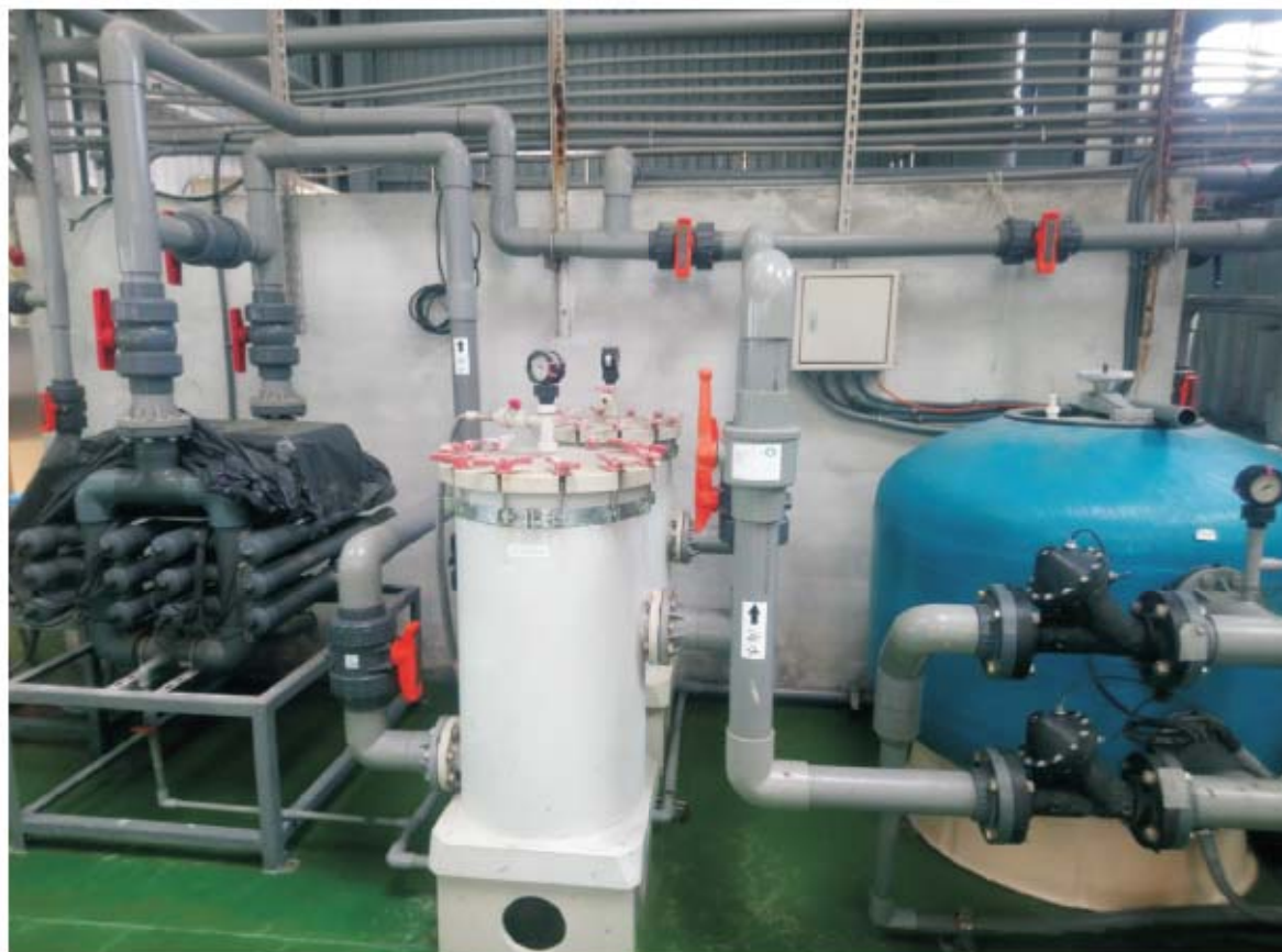
▲ 過濾殺菌設備（由右至左依序為砂濾機、精密過濾器及UV燈殺菌設備）
