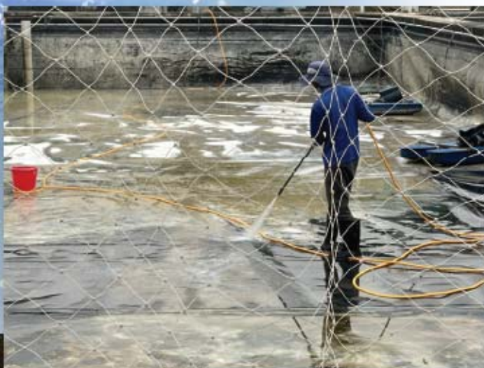
▲ 利用高壓水柱沖洗 HDPE 膜池
