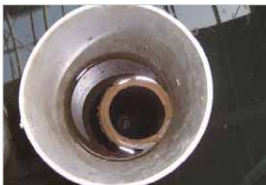
圖 4-14 魚池雙套管排水口
