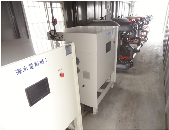
圖 8-6 石斑魚模場電解水消毒過濾系統
