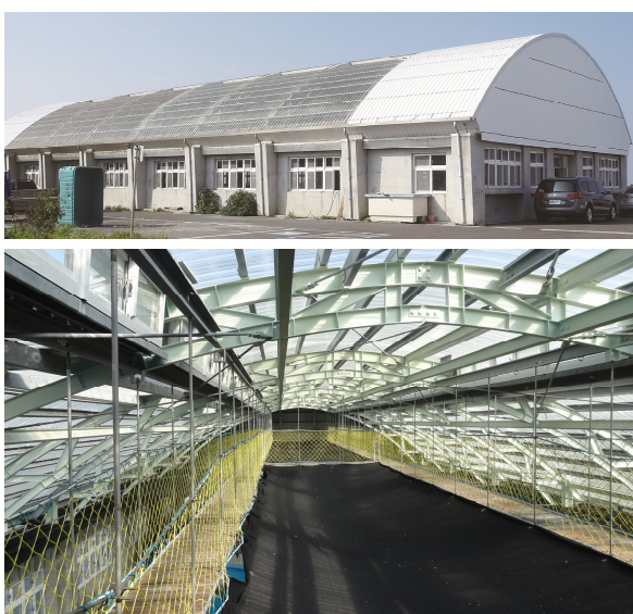
圖 8-3 育苗場屋頂以透明浪板覆蓋，並增設屋頂排熱窗進行溫度調節
