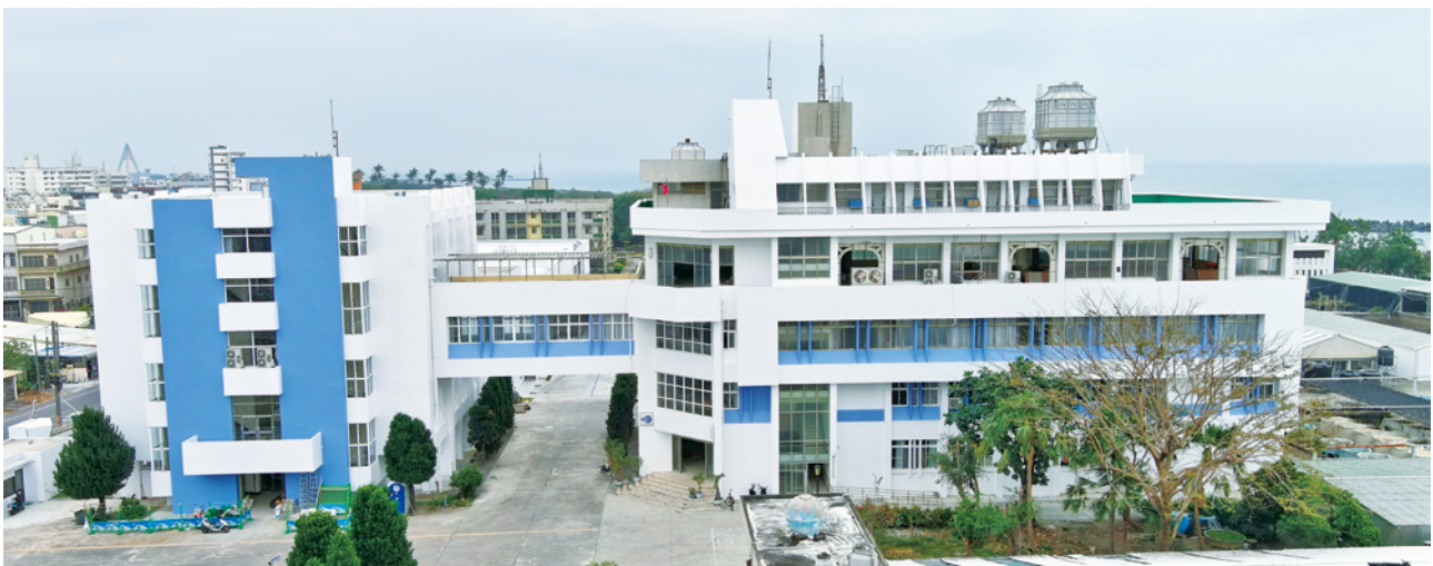
東港養殖研究中心行政大樓 AB 兩棟完成耐震補強工程
