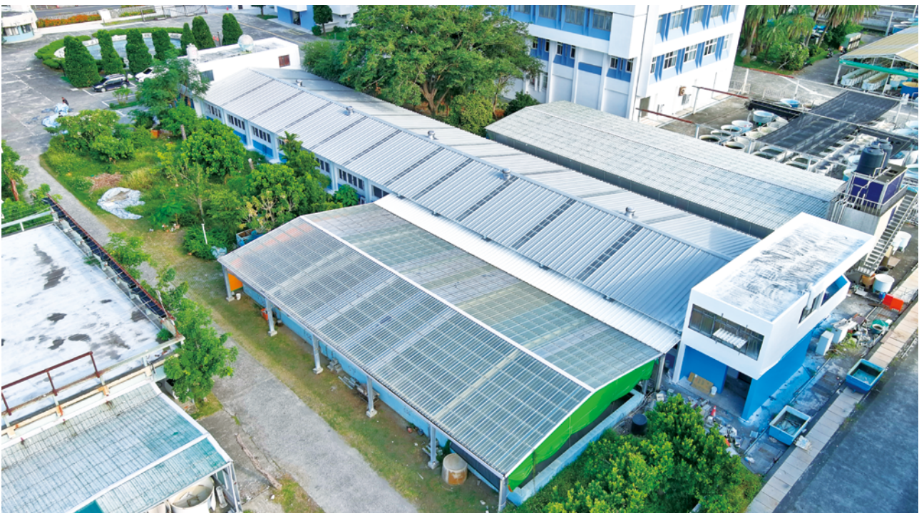
屋棚整修完成之草蝦種蝦保溫室
