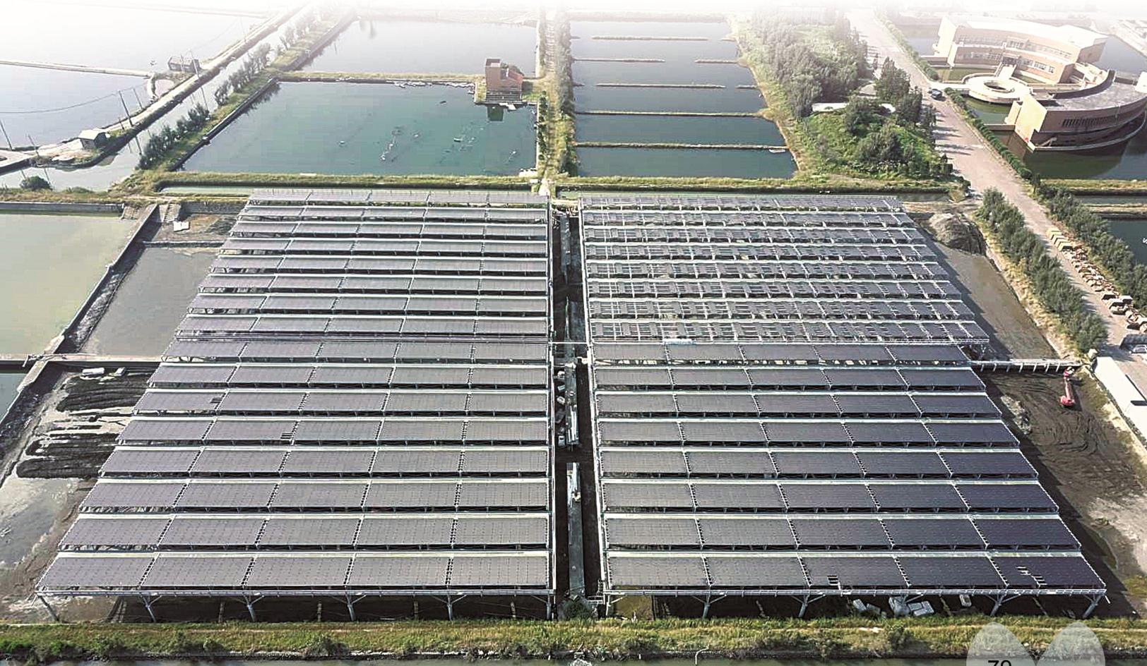
圖 8-2 文蛤池立柱型太陽能板設施之試驗場所
