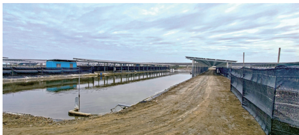
圖 4 堤岸廊道型漁電共生養殖池遮蔽率 30%，池子的北側架設防風棚來阻擋北風
