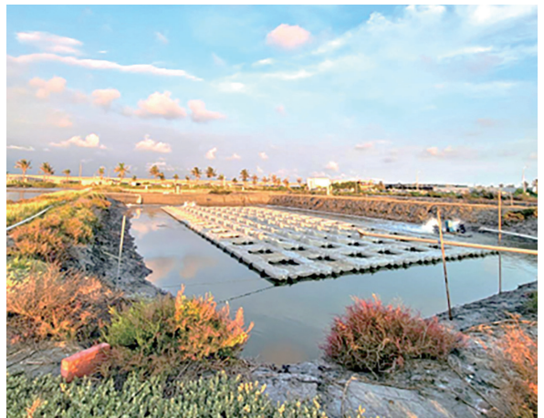
圖 2 模擬浮動型漁電共生養殖池，池子上方浮筏的遮蔽率為 50%
