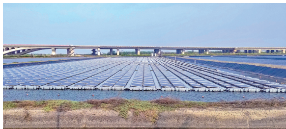
圖 5 浮動型漁電共生養殖池，太陽能板遮蔽率為 70%
