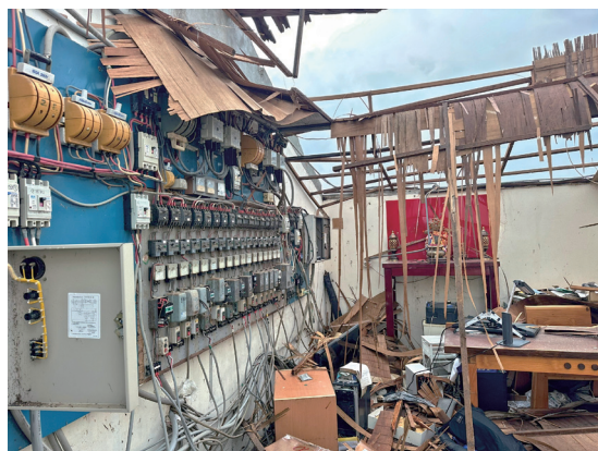
圖 1 颱風過後 1 天，魚塢工寮屋頂被掀，配電盤進水（陳國偉提供）
