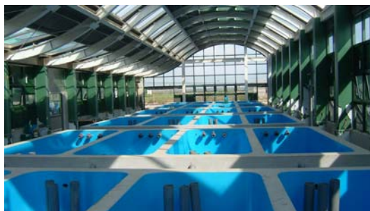
圖 6 保種溫室－B 棟之內部設施
