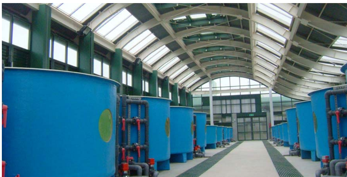
圖 7 保種溫室－C 棟之內部設施
