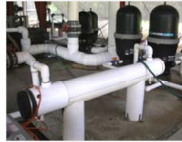
圖 6 黃鰭鮪種魚飼育池之沙濾器、紫外線殺菌系統及管路設施
