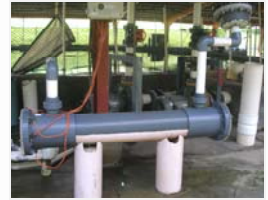
圖 6 黃鰭鮪種魚飼育池之沙濾器、紫外線殺菌系統及管路設施
