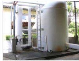
圖 7 黃鰭鮪種魚飼育池之蛋白質除沫器、打氣增氧水塔及其供水系統
