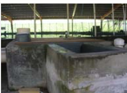
圖 4 黃鰭鮪種魚飼育池之排水陰井及排水管路
