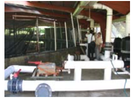
圖 7 黃鰭鮪種魚飼育池之蛋白質除沫器、打氣增氧水塔及其供水系統
