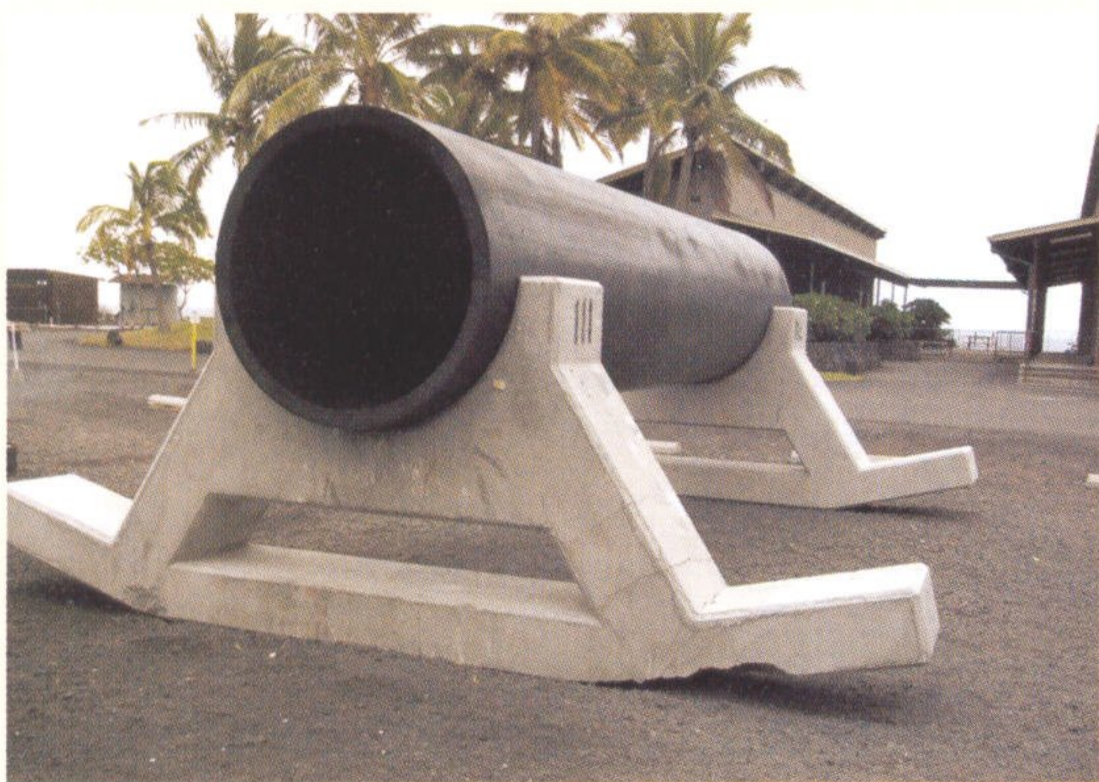
圖 9 夏威夷大島海洋深層水取水管及壓重設備
