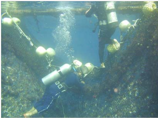
圖3 連接新舊兩箱網間的網目以製作魚道
