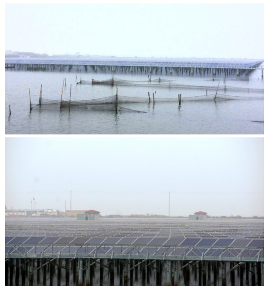
圖1 寧波慈溪周巷水庫與長河水庫立柱型太陽能發電設施
