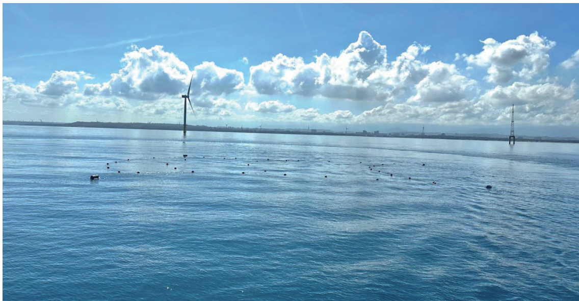
圖 1 建置於苗栗外海的海洋風電海氣象觀測塔附近的改良式海洋人工表層藻場設施
